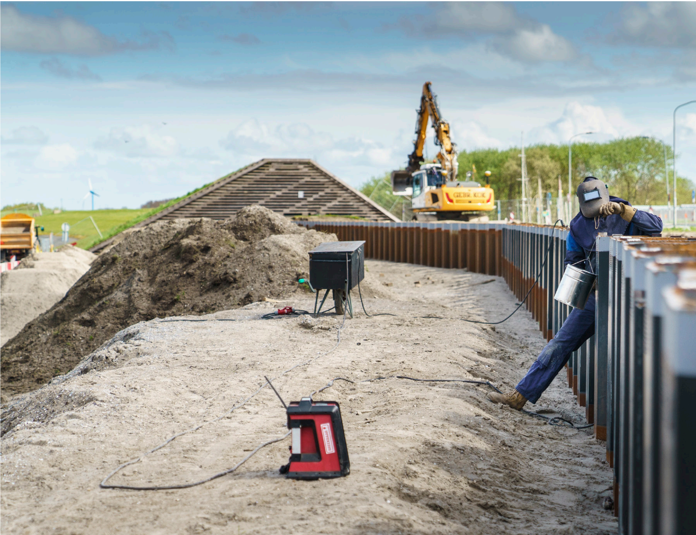
Werkzaamheden dijkversterking Lauwersmeerdijk-Vierhuizengat.
