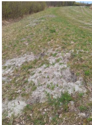
foto, kale plekken en graafschade
