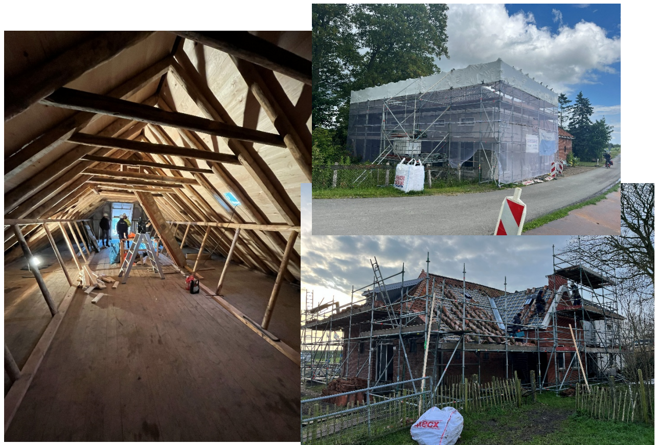
Foto: restauratie kapschuur en gevel voorhuis Waarhuis Schaphalsterzijl
