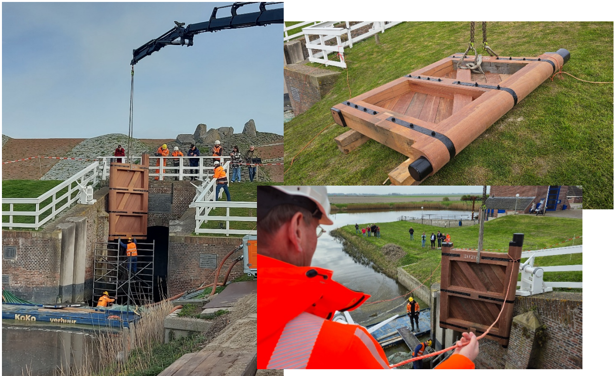
Foto: officieel moment inhangen houten sluisdeuren Oude Sluis Noordpolderzijl
