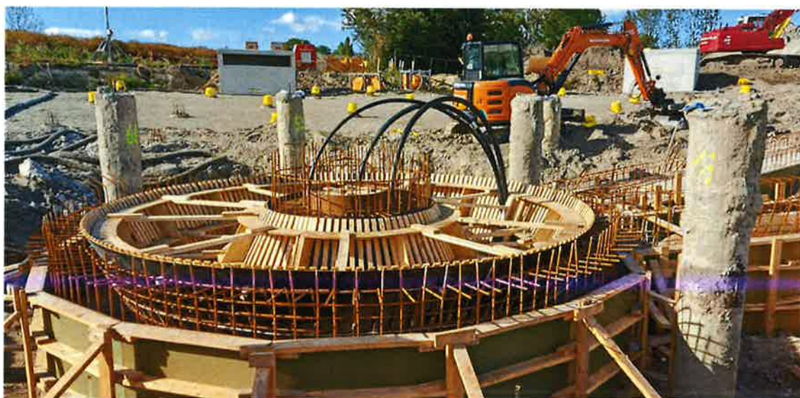
Hart van de nabezinktank bij RWZI Gaarkeuken
