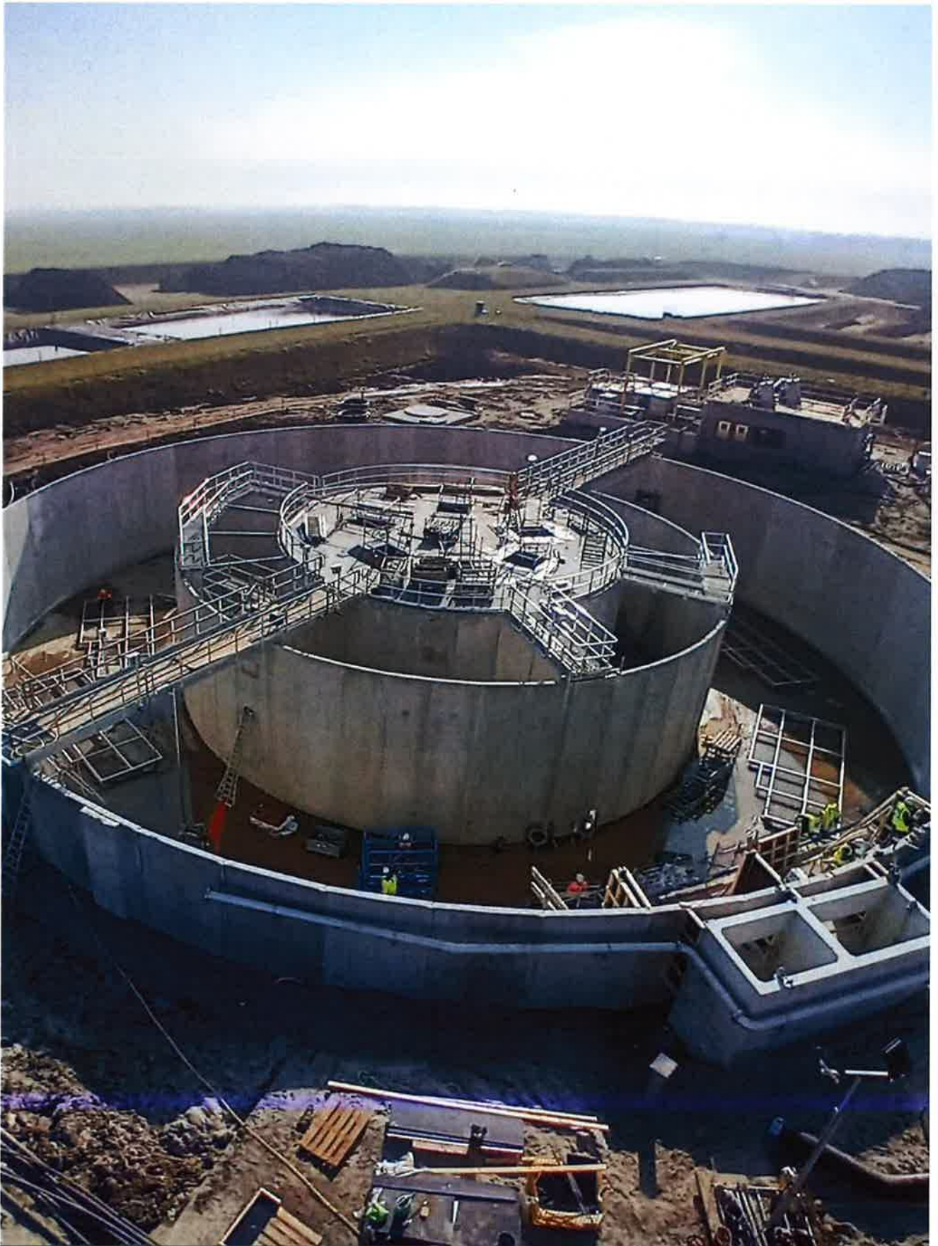
Bouw van de nabezinktank bij RWZI Gaarkeuken
