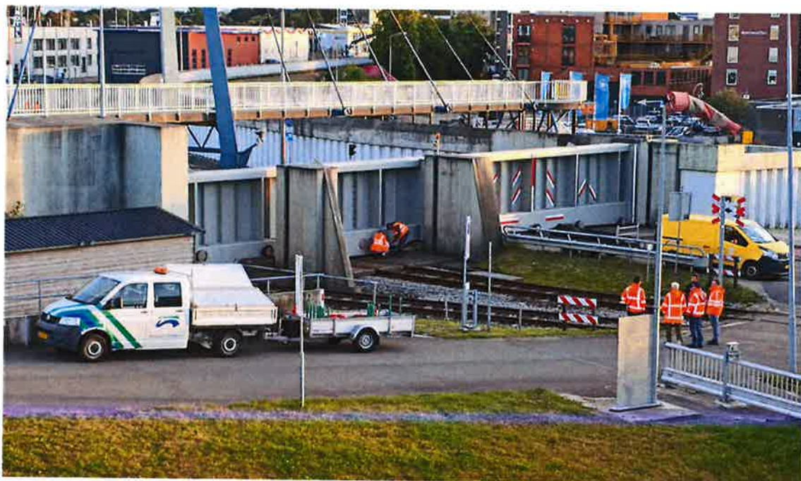
De coupures (dijkdoorgangen) in Delfzijl worden door Waterschap Noorderzijlvest gesloten
