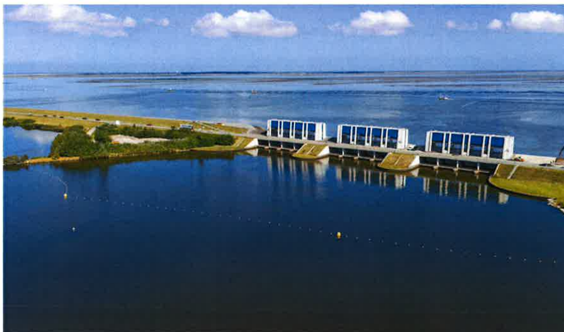
Cleveringsluizen tussen het Lauwersmeer en de Waddenzee
