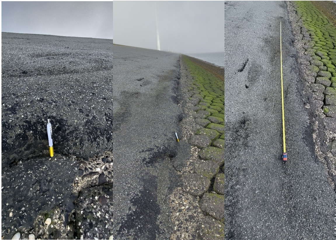
Figuur 8 uitvloeien asfaltbekleding Oostpolderdijk
