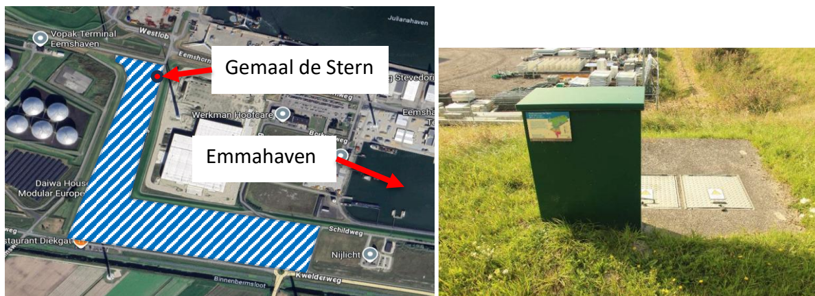
Figuur 20 Gemaal De Stern
