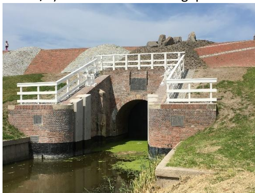
Figuur 16 Voormalige uitwateringssluis Noordpolderzijl
