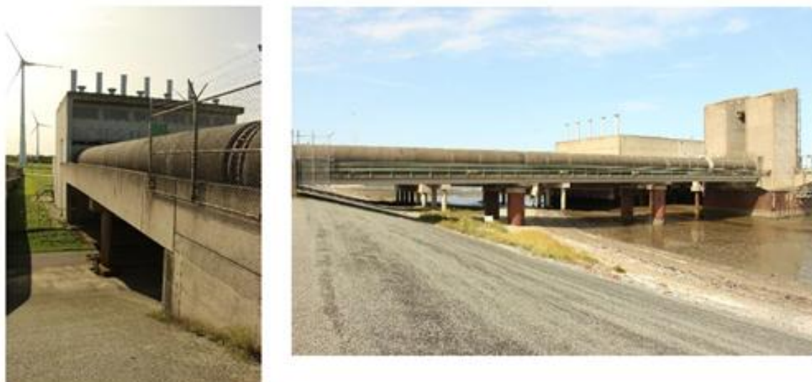
Figuur 24 Koelwaterinlaat Eemscentrale
