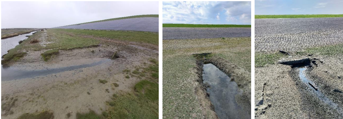
Figuur 34 voorbeelden van zeewaartse uittreding zoetwater uit de kering
