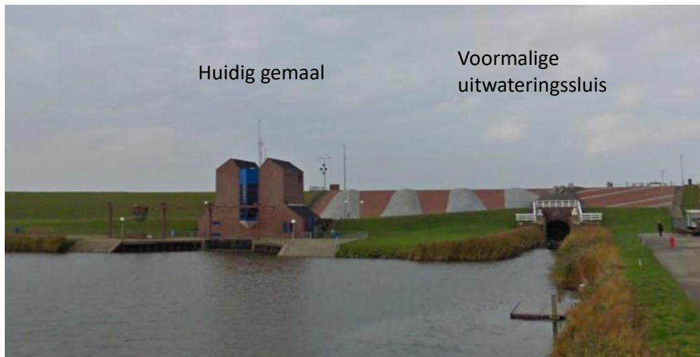
Figuur 19 gemaal Noordpolderzijl en voormalige uitwateringssluits Noordpolderzijl
