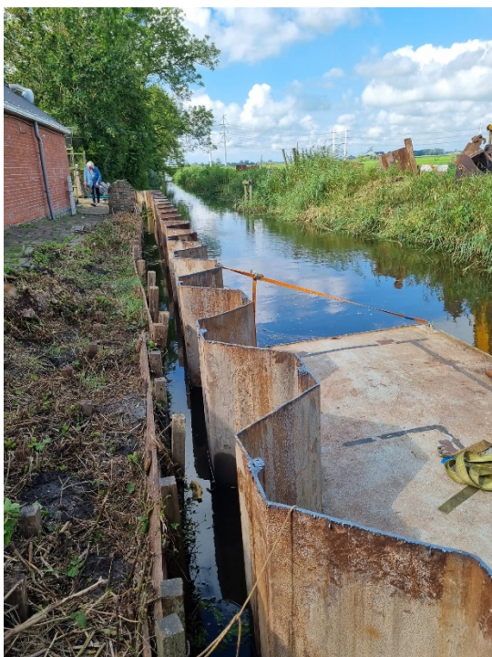
Damwand Oude Ae bij boerderij. Vervanging ca 40 m houten damwand bij particulier (2024).
