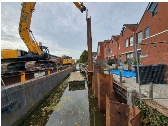
Kademuur Smederij Appingedam. Plaatsing hoge stalen damwand langs tuinen woningen van woonstichting Groninger Huis. Gezamenlijk project en financiering (2024).
