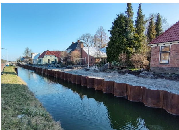
Damwand Lopster Wijmers. Vervanging 300 m houten damwand voor stalen damwand (2026). Initiatief gemeente Eemsdelta met bijdrage van waterschap.
