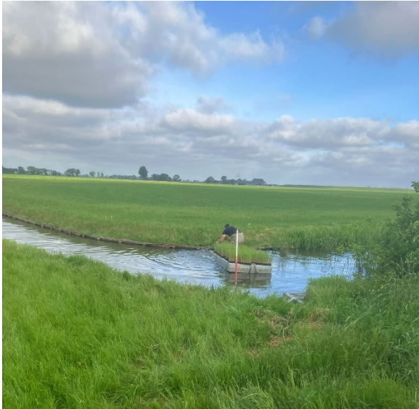
Middelagerriet. Plaatsen palen met wiepen, aanplant riet en verflauwen taluds langs ingezakte oevers meerdere watergangen (2023).
