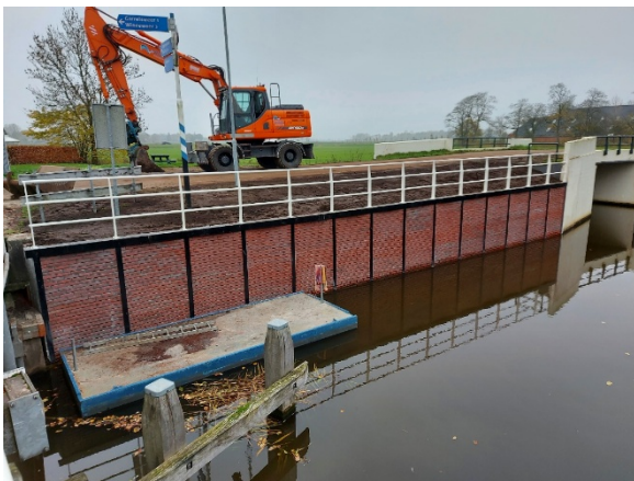
Kademuren Wirdumerdraai. Vervanging 2 kademuren met oog voor historische stijl (metselwerk in cubbestijl) (2021). Overdracht naar gemeente Eemsdelta.
