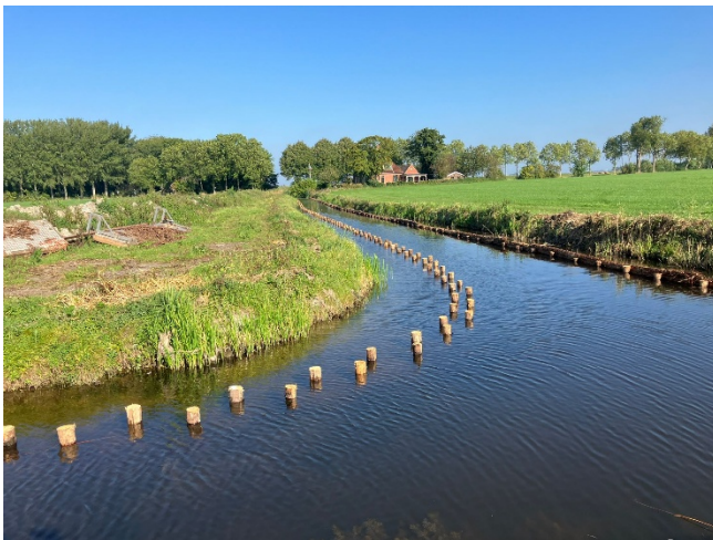
Gebied Hoeksmeer nabij gemaal Katerhals. Plaatsen beschoeiing en verflauwen taluds langs ingezakte oevers meerdere watergangen (2023).
