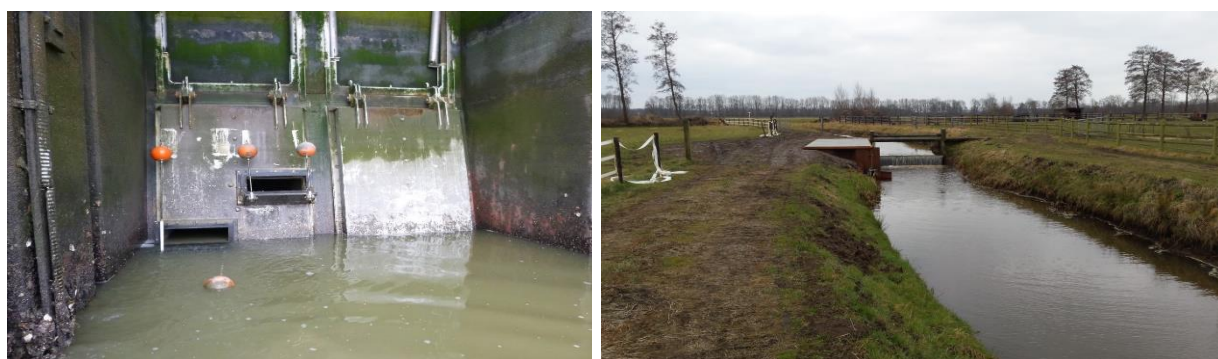
Afbeelding 3a & b: Als onderdeel van het gebiedsgerichte spoor zijn er o.a. vismigratie voorzieningen gerealiseerd bij gemaal Spijksterpompen (links) en bij de Donderen-Norgstuw (rechts).
