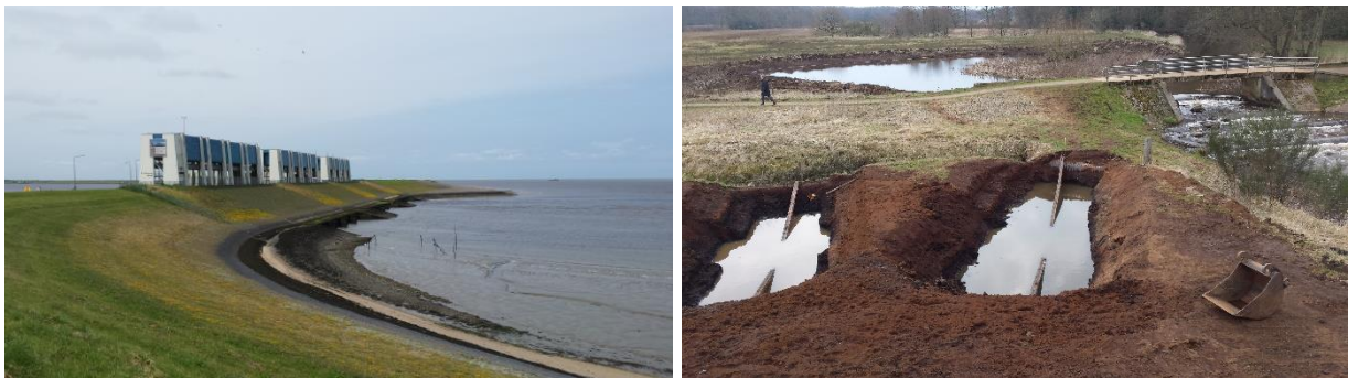
Abbeelding 1a & b: Visvriendelijk spuisluisbeheer bij de Cleveringsluizen (links) biedt vissen een mogelijkheid om het beheergebied in te trekken. Verder stroomopwaarts werkt Noorderzijlvest aan het verder optrekbaar maken van de vismigratieroutes, o.a. door de optimalisatie van de Sterrebosvistrap middels een bypass (rechts).
