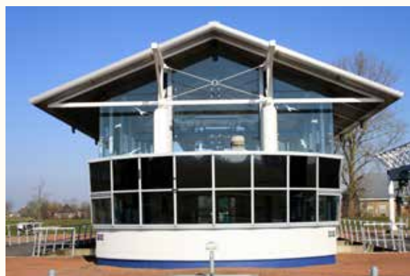
Gemaal Den Deel
