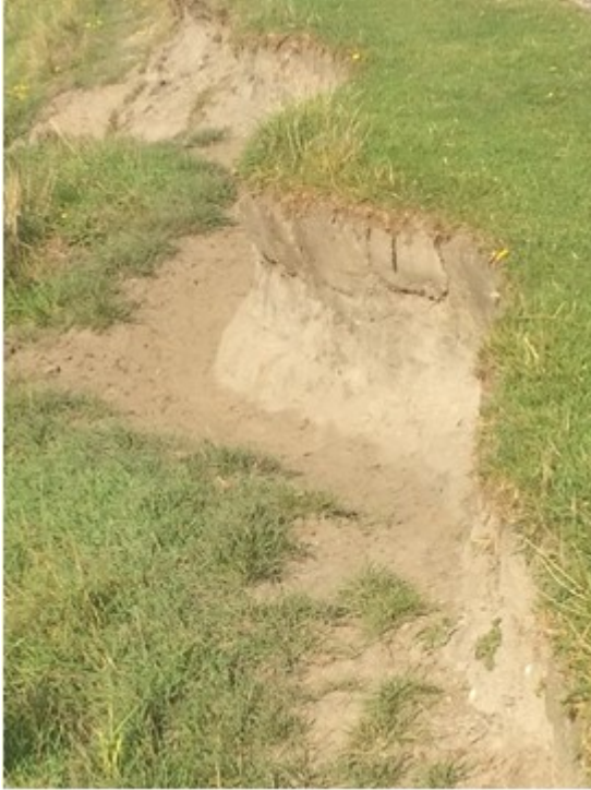
Beschadigd talud
