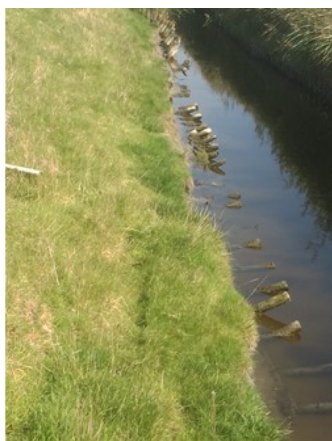
Toestand oeverbeschoeiing
