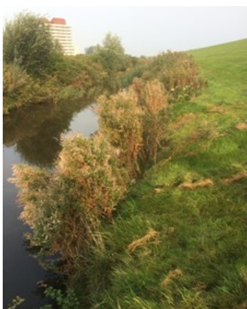
Steil binnentalud in combinatie met onderhoudstoestand beschoeiing
