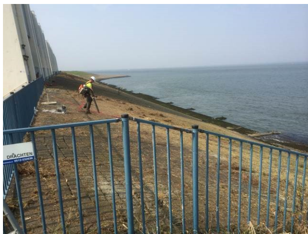
Maaien en afvoeren ongewenste begroeiing R.J Ceveringsluizen
