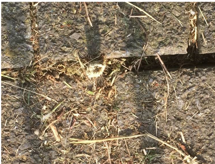
Houtachtige begroeiing tussen kopperslakkblokken ter plaatse van de R.J. Cleveringsluizen
