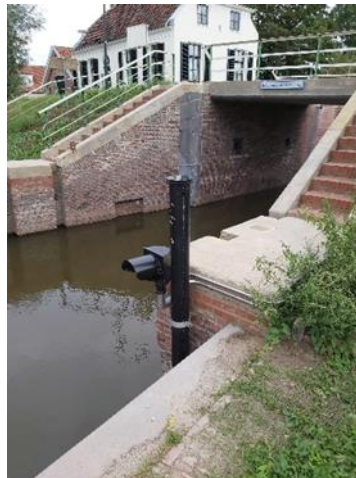
Sluis Schouwerzijl – in functie
