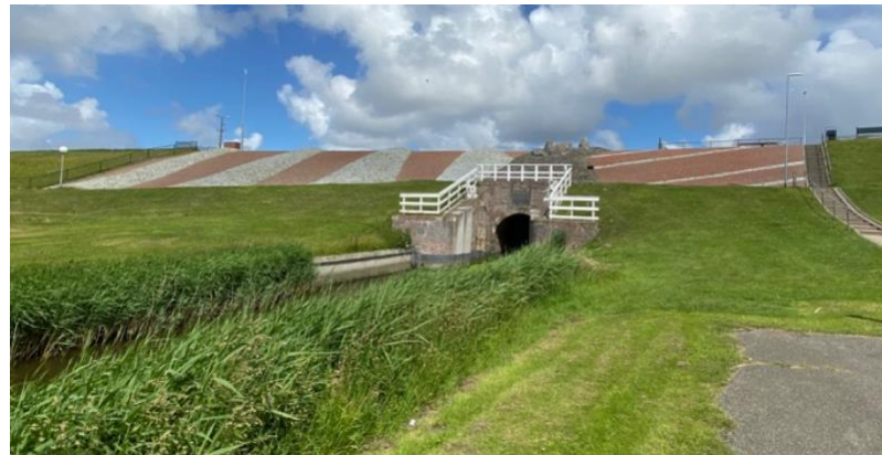
Sluis Noordpolderzijl – niet meer in functie
