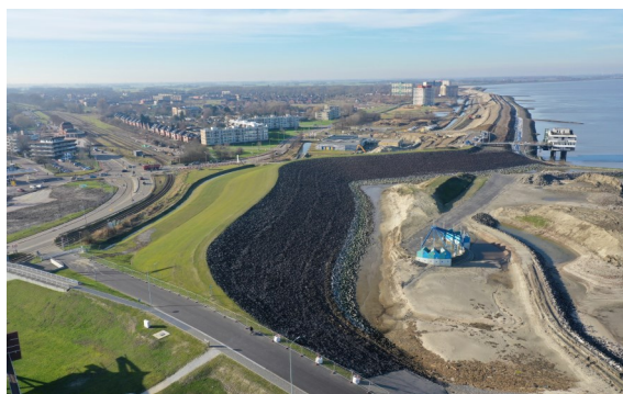
De nieuwe dijk bij het toekomstige stadsstrand is klaar. De dijk en fundering voor de parkeerplaatsen tussen Eemshotel en MuzeeAquarium wordt deze zomer afgerond.
