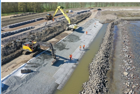
Bij Voolhok komen betonnen blokken op de buitenzijde (Hillblocks).
