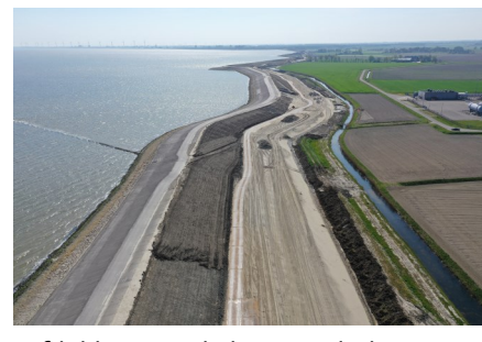
Afdekken van de binnentalud met klei.
