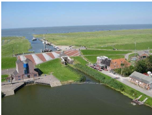
Foto 6. Sluis en kunstwerk op de dijk te Noordpolderzijl
