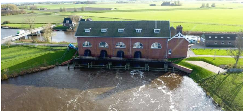
Foto 5. Gemaal De Waterwolf (rijksmonument)
