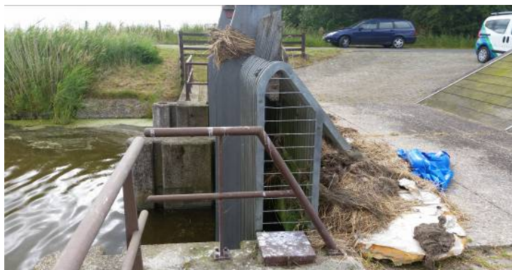
Figuur 2.6 Gemaal De Delthe instroomzijde (kroosvoorziening)
