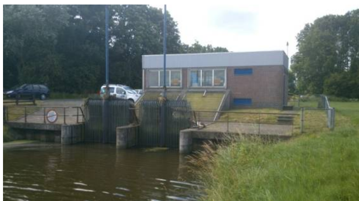
Figuur 2.5 Aanzicht gemaal De Delthe, instroomzijde
