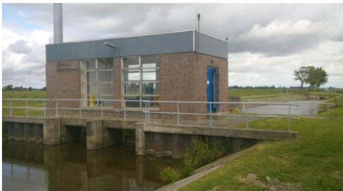
Figuur 2.3 Aanzicht gemaal Sichterman (uitstroomzijde)
