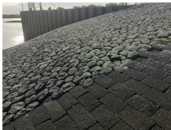
Figuur 6. Aansluiting op basaltzetting kop havendam.
