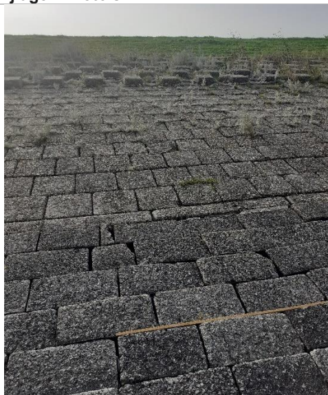
Figuur 3. Van onder naar boven: koperslakblokken, betonband, betonblokken, diaboolblokken.
