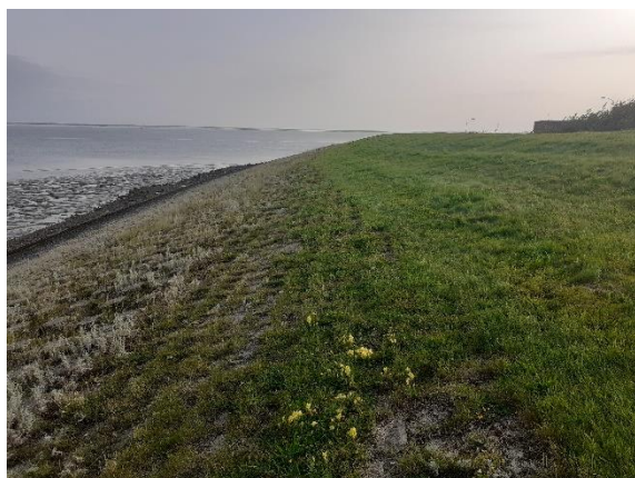
Figuur 5. Betonblokken en grasbekleding boven diaboolgooiing.
